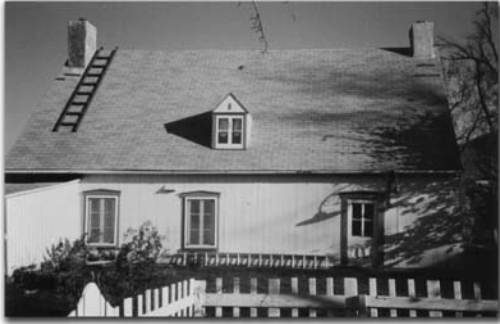
La maison Robert, 1 100, rue Richelieu, Beloeil. Source : SHBMSH
